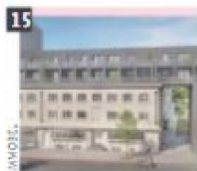
15 Canal44 Esch-sur-Alzette 72 logements
